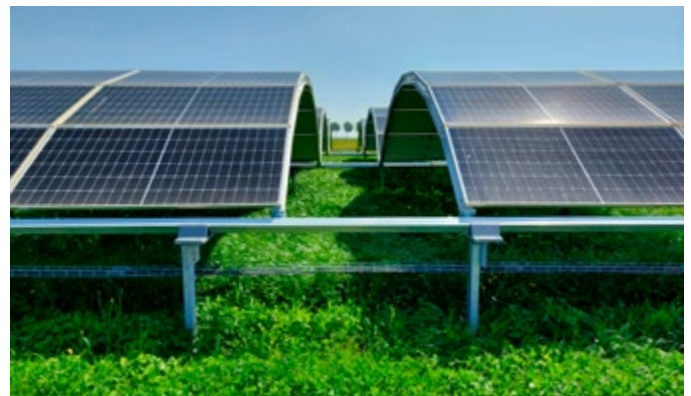
Figuur 2 Boven: panelen boven peren (systeem Groenleven; foto: Frank de Ruijter). Onder: Verrijdbare zonnepanelen van GOLDBECK SOLAR/Solarvation boven gras/klaver (foto: Jan-Rinze van der Schoot).
